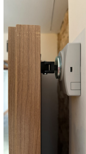
CIERRE DE SEGURIDAD Electro hold open magnets
